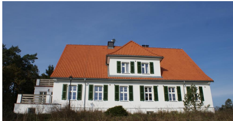
Zabytkowa leśniczówka - izolacja posadzki, izolacja ścian na elewacji, izolacja wew. dachu
